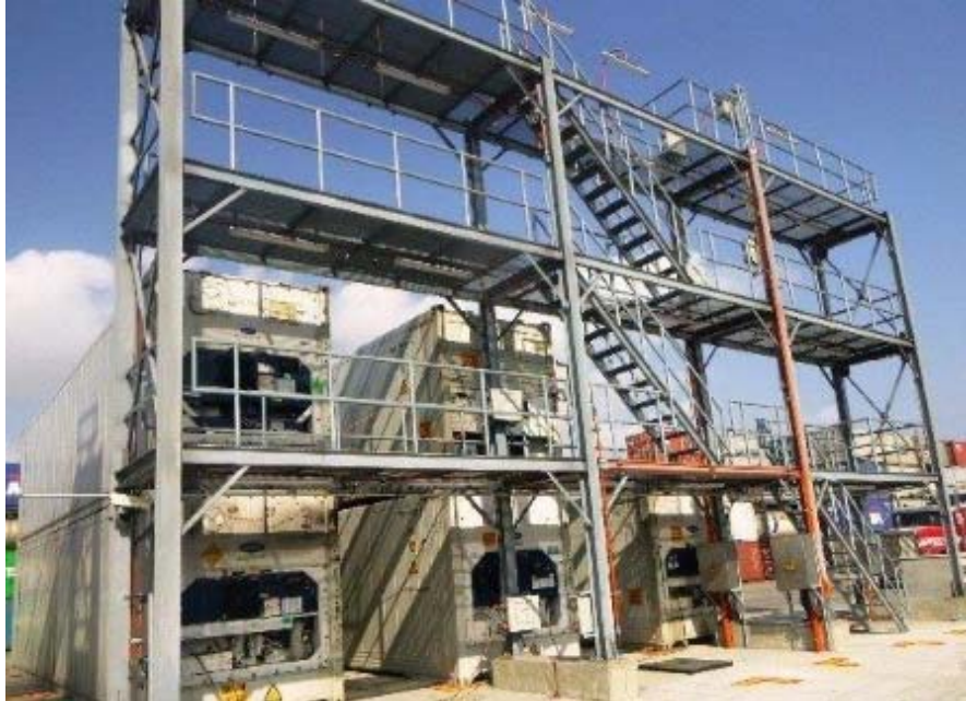
Ilustración 6. Zona para contenedores frigoríficos. Fuente: Sociedad Puerto de Barranquilla
