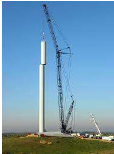
Figura 37. Instalación de la torre de un aerogenerador.
