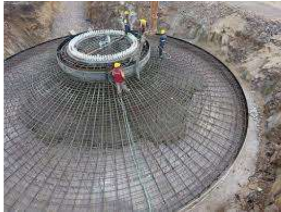
Figura 35. Preparado de cimentación para un aerogenerador en tierra.
