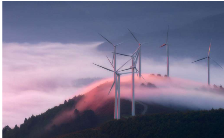
Figura 31. Agrupación de aerogeneradores formando un parque eólico.
