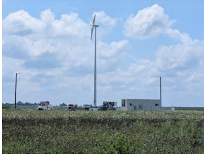
Figura 5. Aerogenerador de 20 kW de la UIUC en su emplazamiento previsto en el campus. Fuente: University of Illinois Urbana-Champaign (2025).
