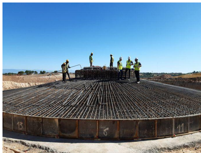
Figura 50. Ejecución de la armadura de una cimentación de aerogenerador [16].
