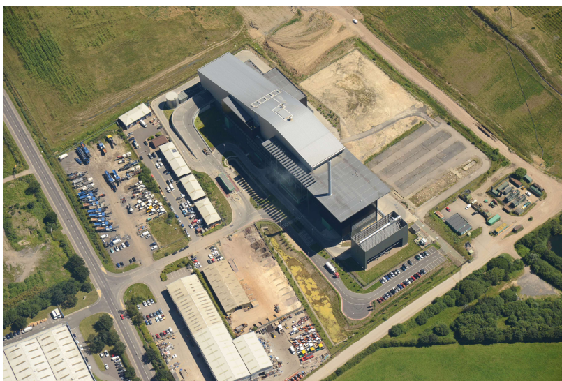
Figura 2 "Vista de la planta de Energy from Waste de Lincoln"
