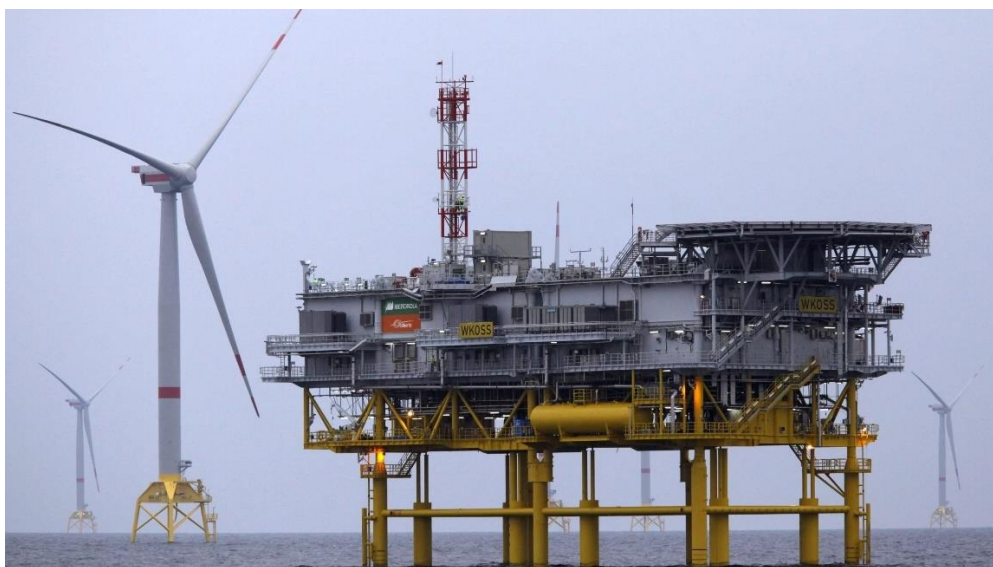
Ilustración 51: Ejemplo de subestación eléctrica offshore (NAVA, 23)
