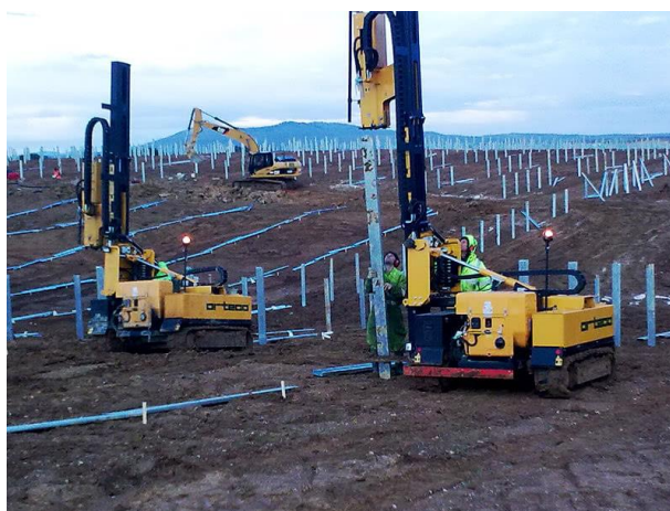
Figura 40. Hincado de estructuras soporte en una instalación solar fotovoltaica [19]
