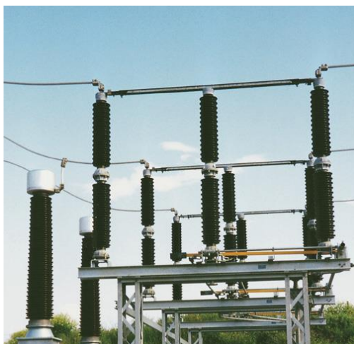
Figura 30 - Seccionador
