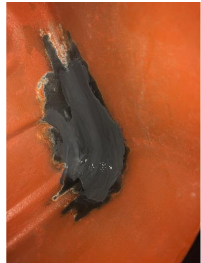
"Refuerzo con epoxi" imagen 44
