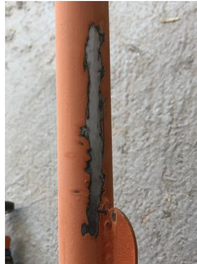
“Lijado cordón de soldadura” imagen 46
