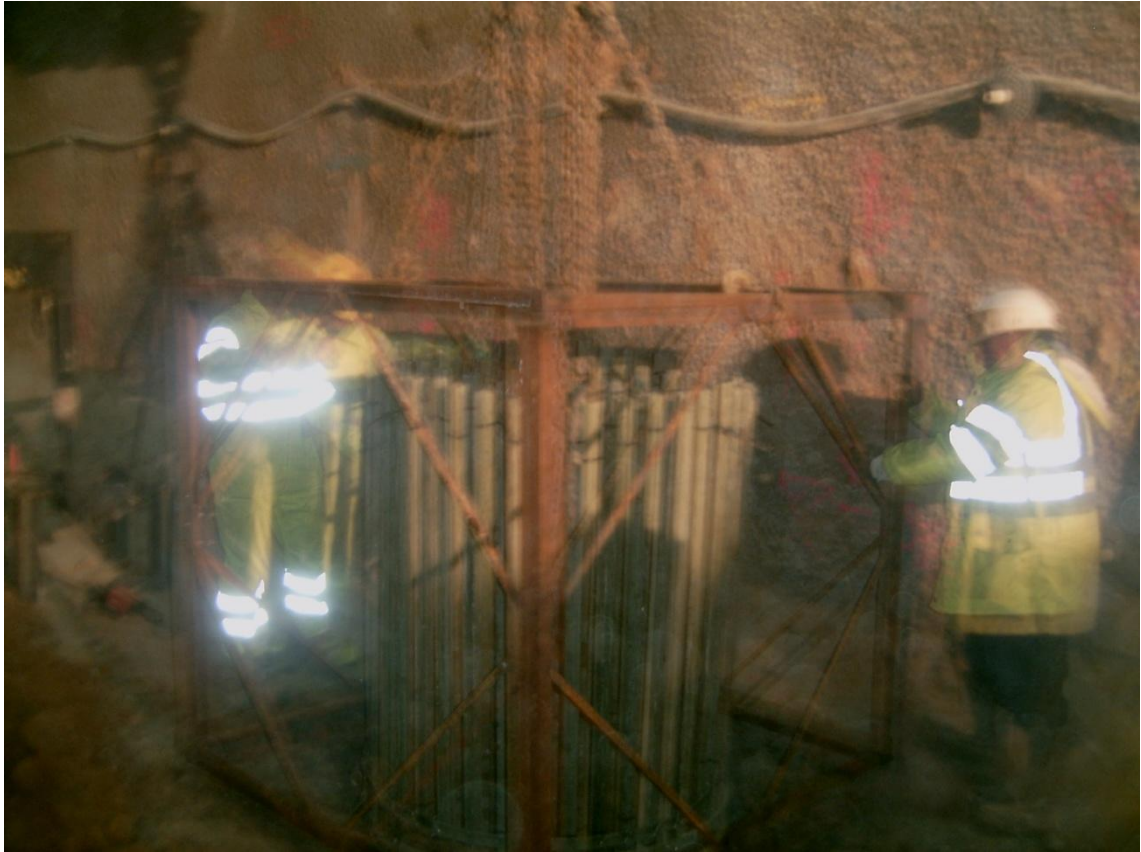
Ilustración 26: Armadura de GFRP colocada en una perforación del Túnel del Regajal.
