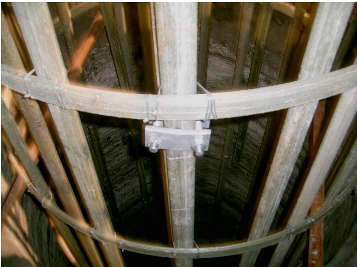
Ilustración 24: Solape de dos tramos de armadura de GFRP en el Túnel del Regajal.
