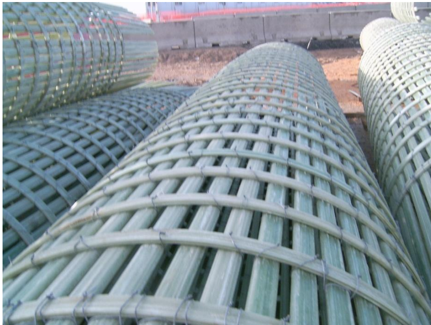
Ilustración 11: Armadura de GFRP de la obra del Túnel del Regajal.
