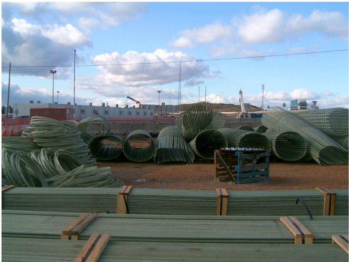
Ilustración 27: Montaje de las armaduras de GFRP en la obra del Túnel del Regajal.
