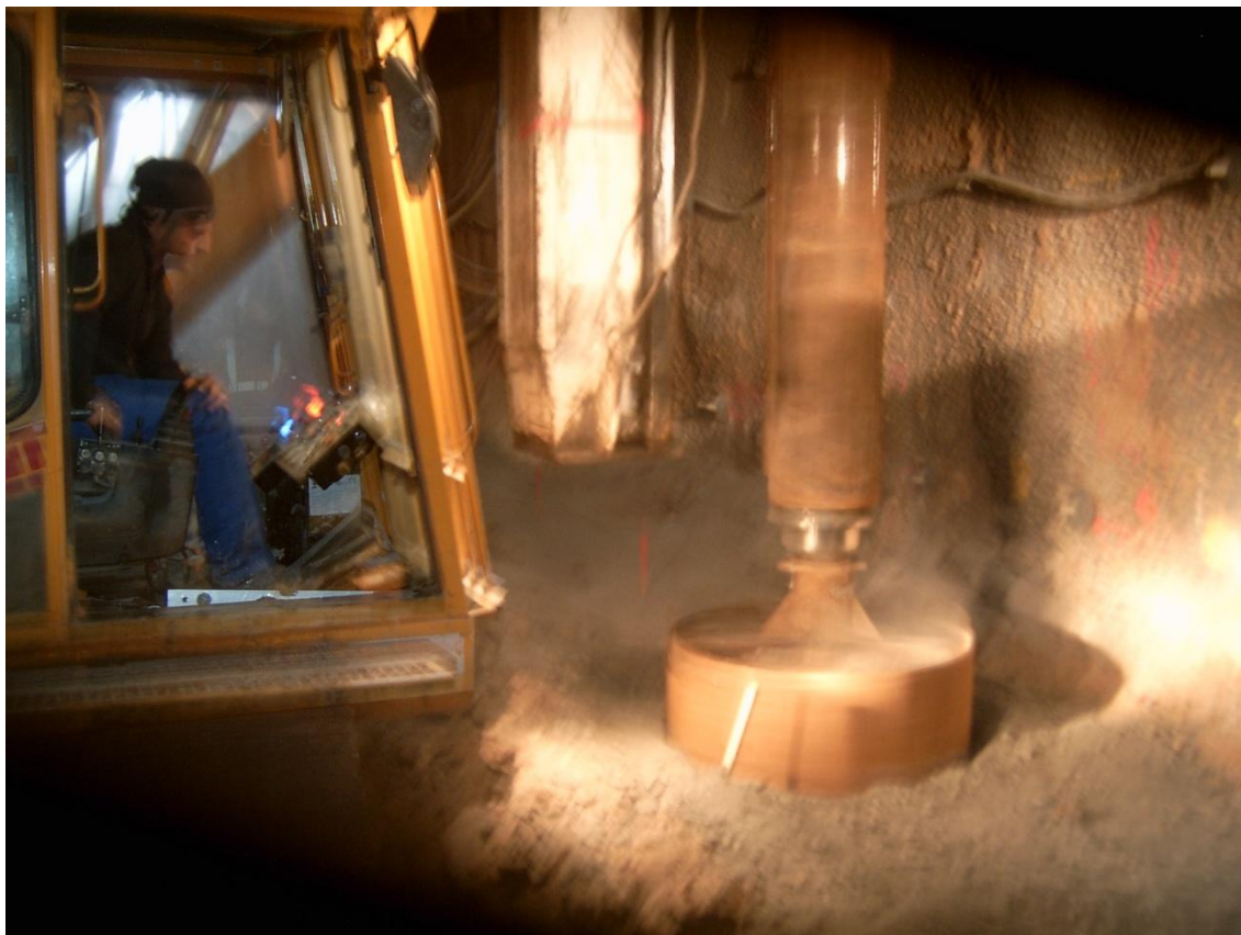
Ilustración 25: Perforación de un pilote dentro del Túnel del Regajal.
