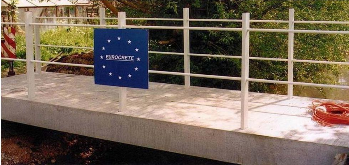
Ilustración 31: Primer puente peatonal de Europa con fibra como refuerzo.
