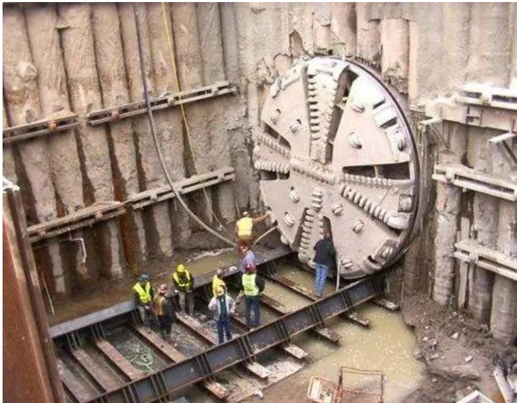
Ilustración 30: Tuneladora en muro pantalla de pilotes armados con fibra.
