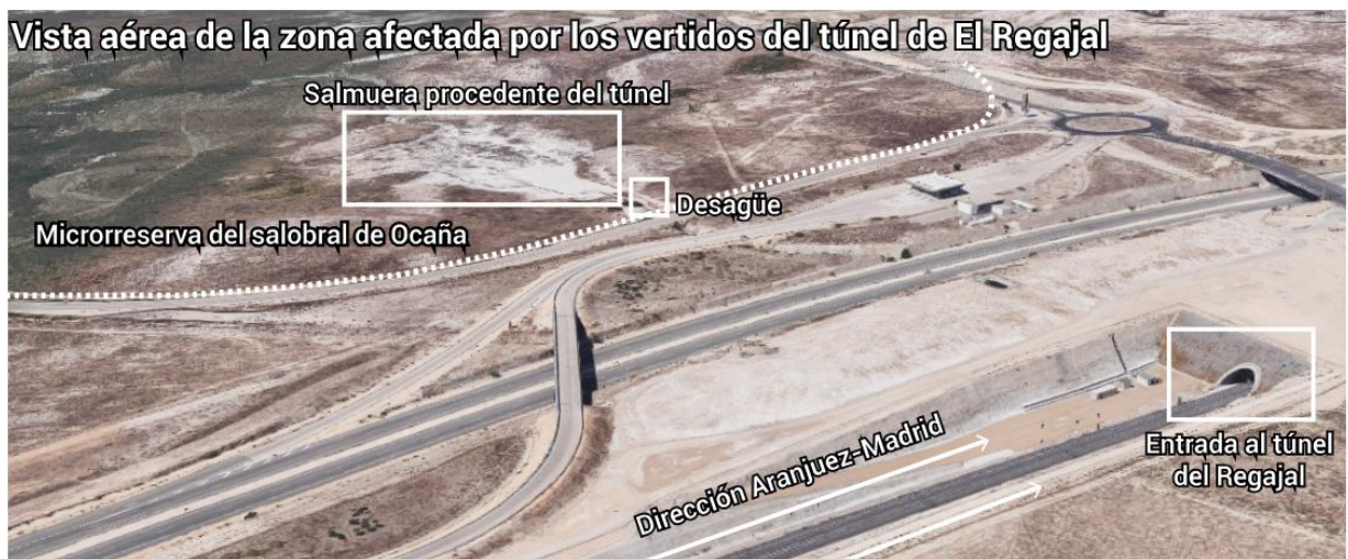
Ilustración 29: Ubicación del desagüe de salmuera del Túnel del Regajal.
