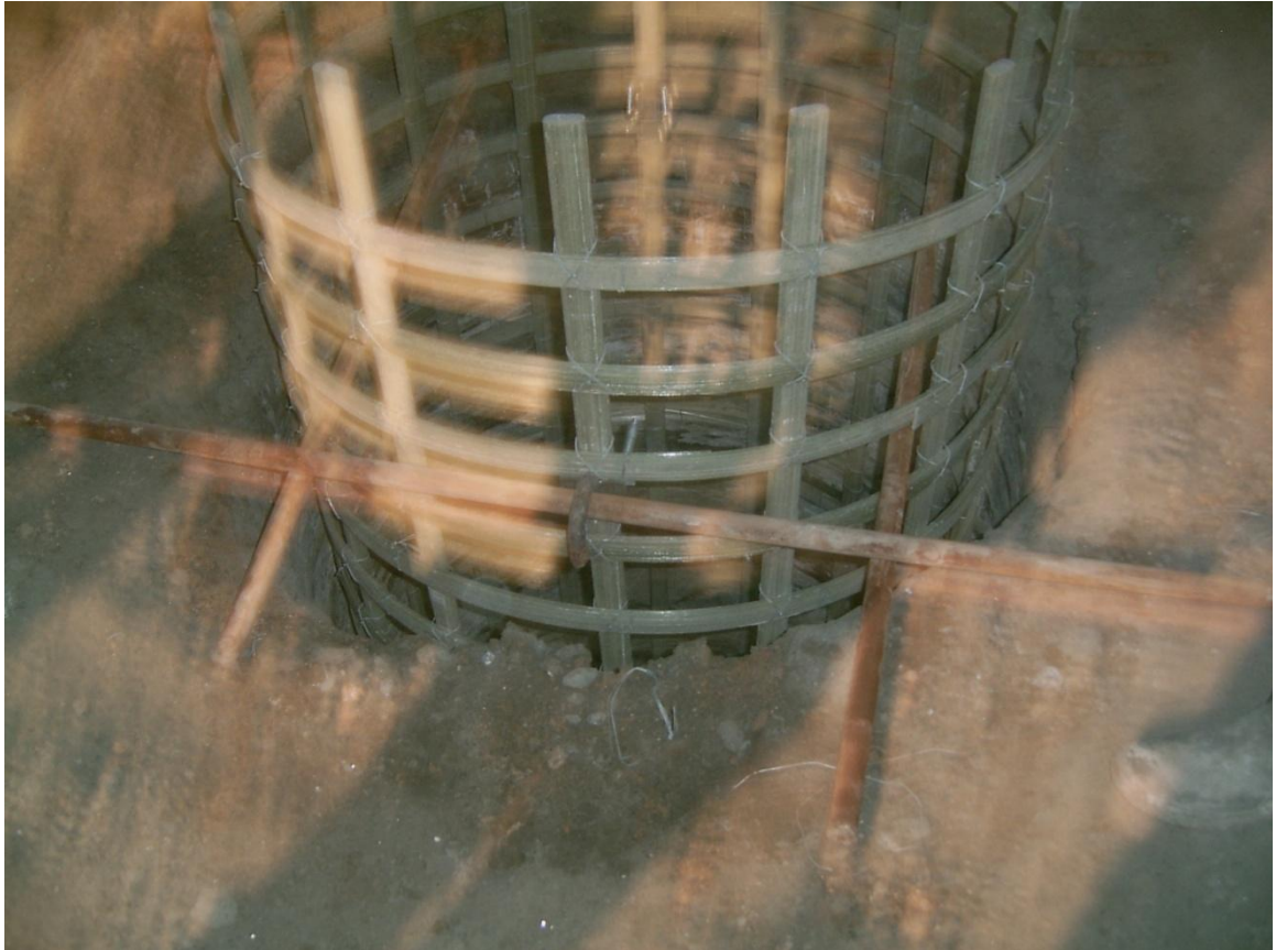
Ilustración 23: Colocación del primer tramo de la armadura de un pilote en el Túnel del Regajal.
