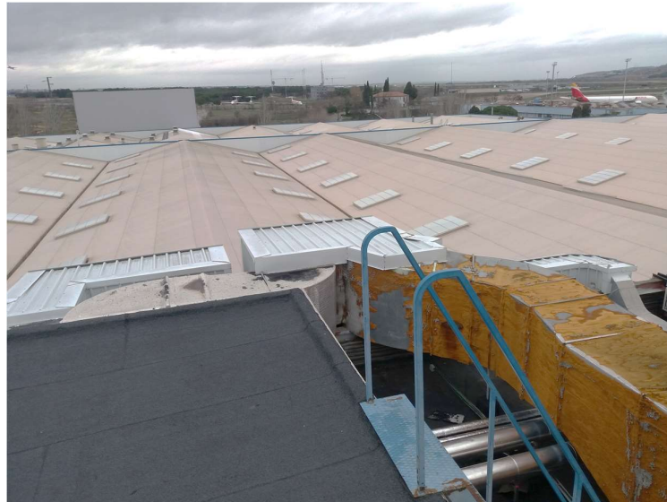
Ilustración 4. Cubierta del edificio.
