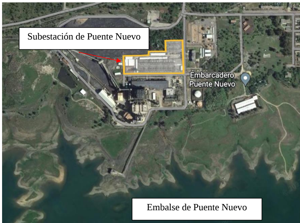
Ilustración 49: Vista cenital de la Subestación de Puente Nuevo. Fuente: Google Earth y elaboración propia.
