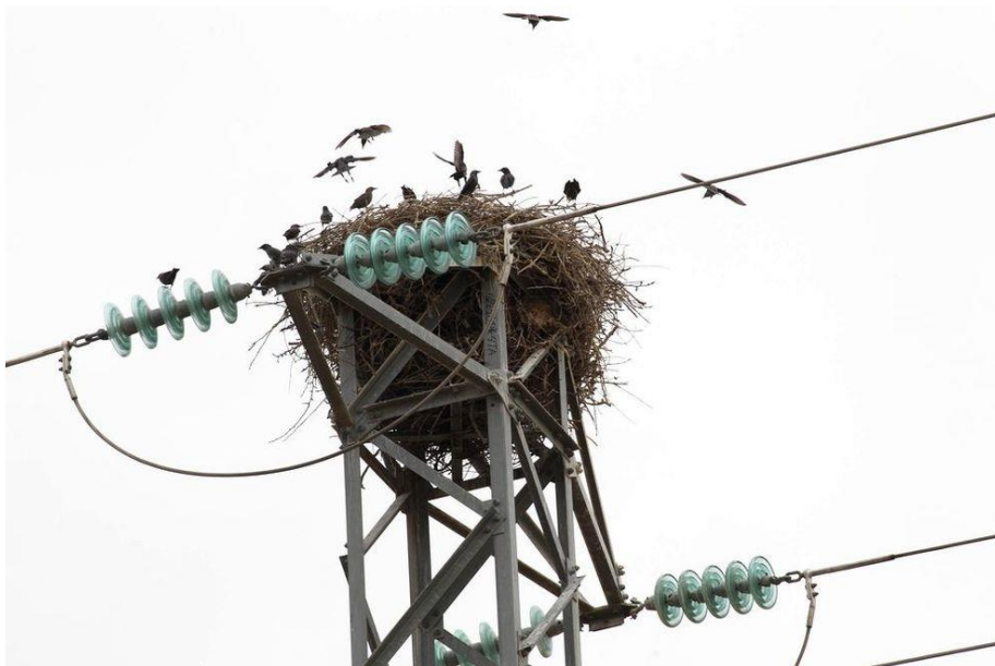
Ilustración 84: Anidaciones de aves sobre línea de media tensión. Fuente: Google photos.
