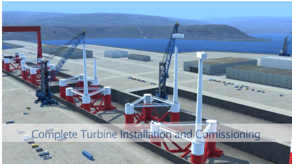
Figura 25. Fase de ensamble del conjunto turbina + estructura en el puerto, fuente: Principle Power.
