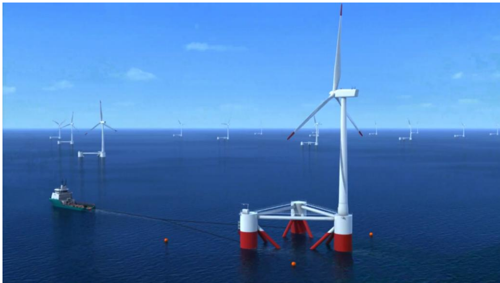
Figura 26. Fase de remolque del aerogenerador montado, fuente: Principle Power [PRIN26].
