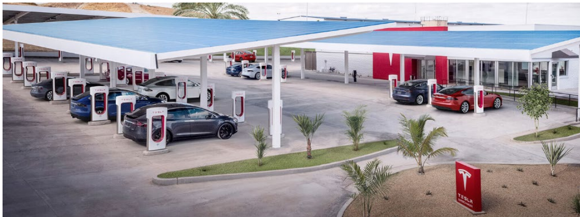
Fig. 1: Estación de carga con generador fotovoltaico de Tesla.
