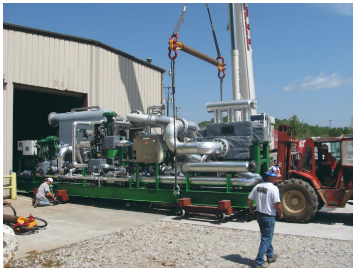
Figura 6-6 Sistema de 8MW de ECHOGEN
