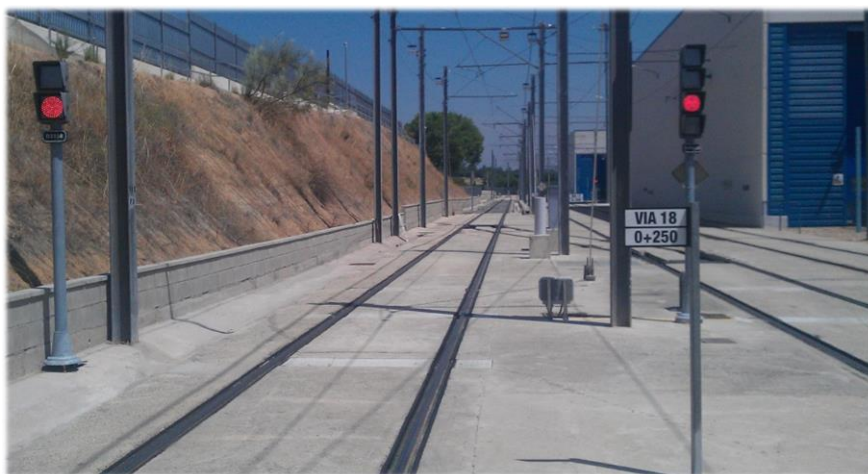
Ilustración 7-2: Detalle de la vía de pruebas disponible en el recinto de Talleres y Cocheras de MLO. [Fuente: Elaboración propia]
