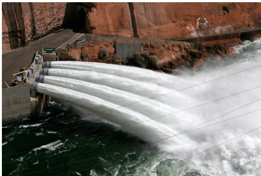
Ilustración 39: Bocas de salida de sistema de desagüe de fondo. [2 5 ]
