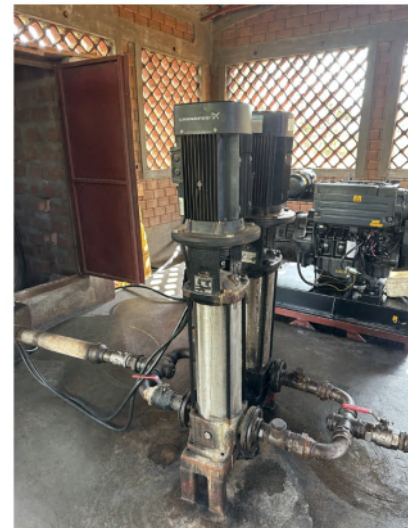
Ilustración 9. Instalación de la bomba del tanque 1 (Imagen de elaboración propia)
