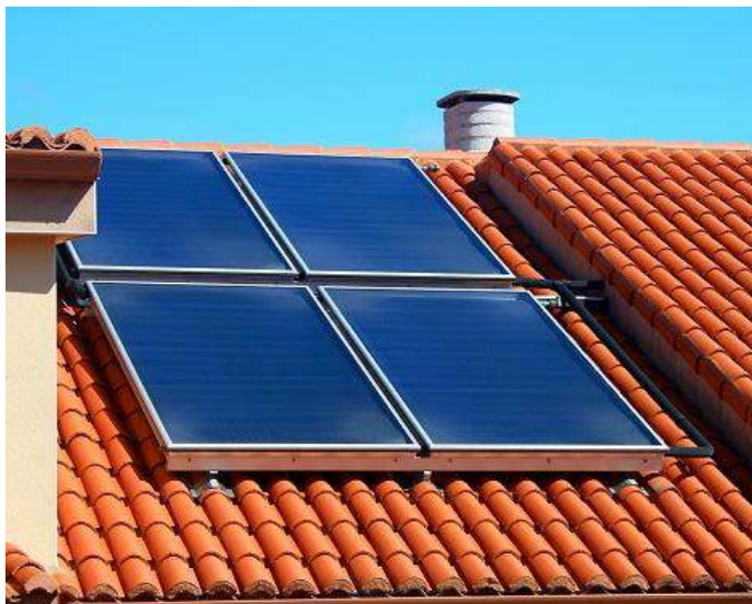
Figura 6. Colector solar plano o panel solar térmico. Fuente: Greenheiss.
