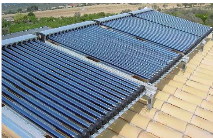
Figura 7. Colector de tubos de vacío. Fuente: Greenheiss.
