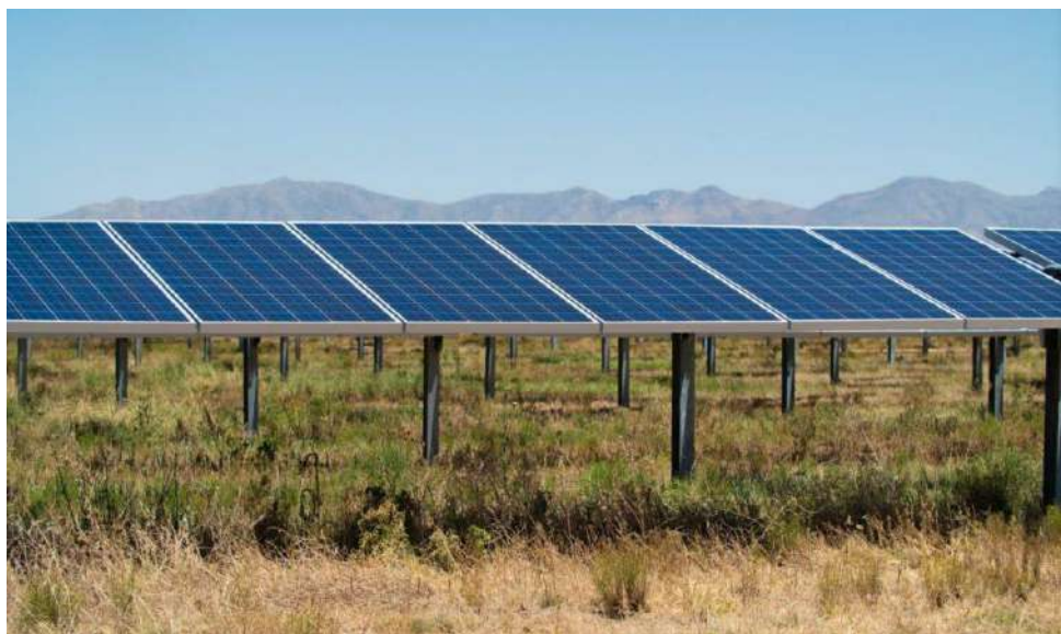
Figura 38. Configuración estructura fija 1V. Fuente: [5]
