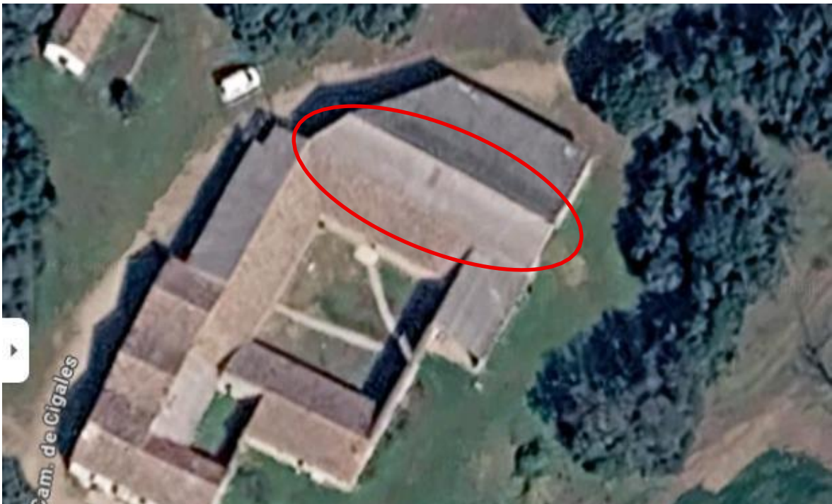
Figura 5.1.4.4 Vista aérea superficie instalación módulos fotovoltaicos
