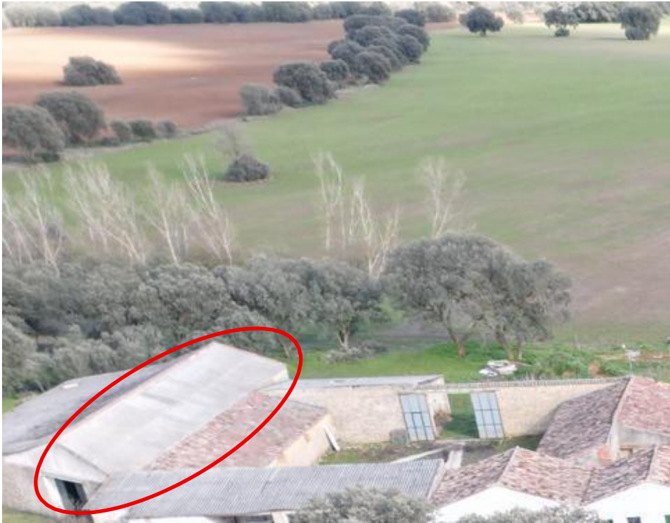
Figura 5.1.4.3 Vista superficie instalación módulos fotovoltaicos
