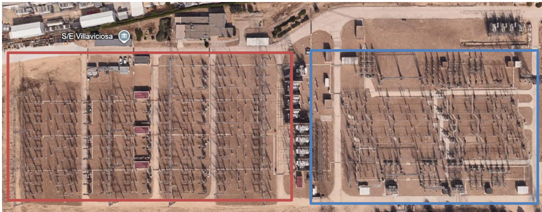
Figura 2. Subestación de Villaviciosa de Odón [GOOG26]
