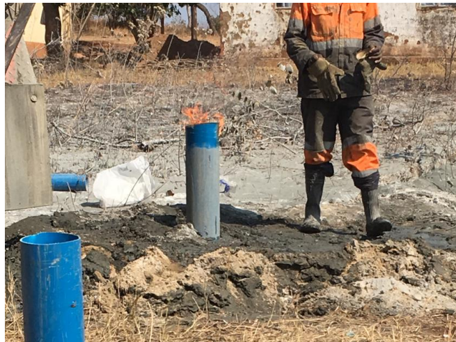
Ilustración 47: Perforación del nuevo pozo
