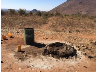
Ilustración 58: Cemento preparado para construir
