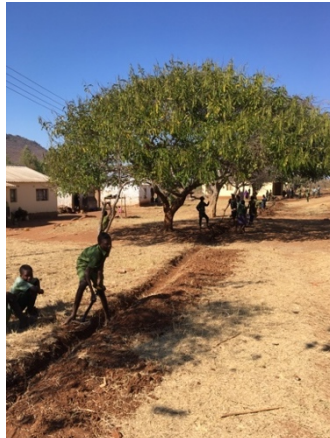
Ilustración 70: Excavación en la zona del colegio
