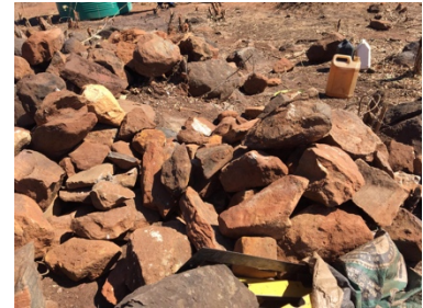
Ilustración 59: Rocas empleadas para la construcción de la estructura
