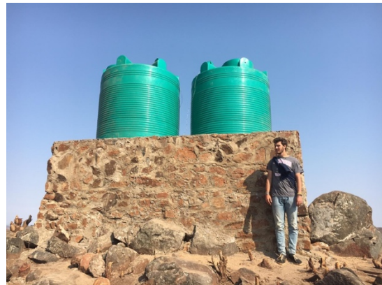
Ilustración 65: Estructura con los tanques instalados
