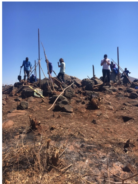
Ilustración 61: Inicio de la construcción
