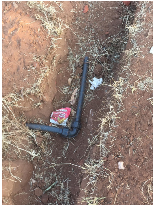
Ilustración 74: Codo para la instalación de un grifo
