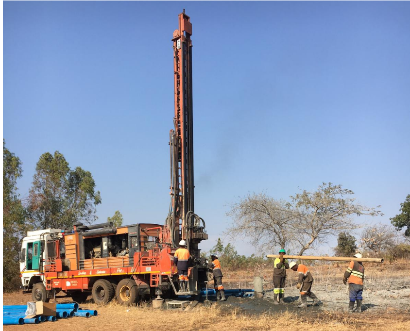
Ilustración 29: Empresa encargada de la perforación del pozo
