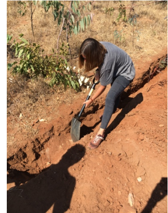
Ilustración 69: Excavación en el tramo de llegada a la estructura de los tanques
