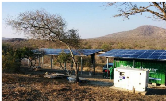
Figura 17: Ejemplo de instalación fotovoltaica aislada en Tanzania [67]
