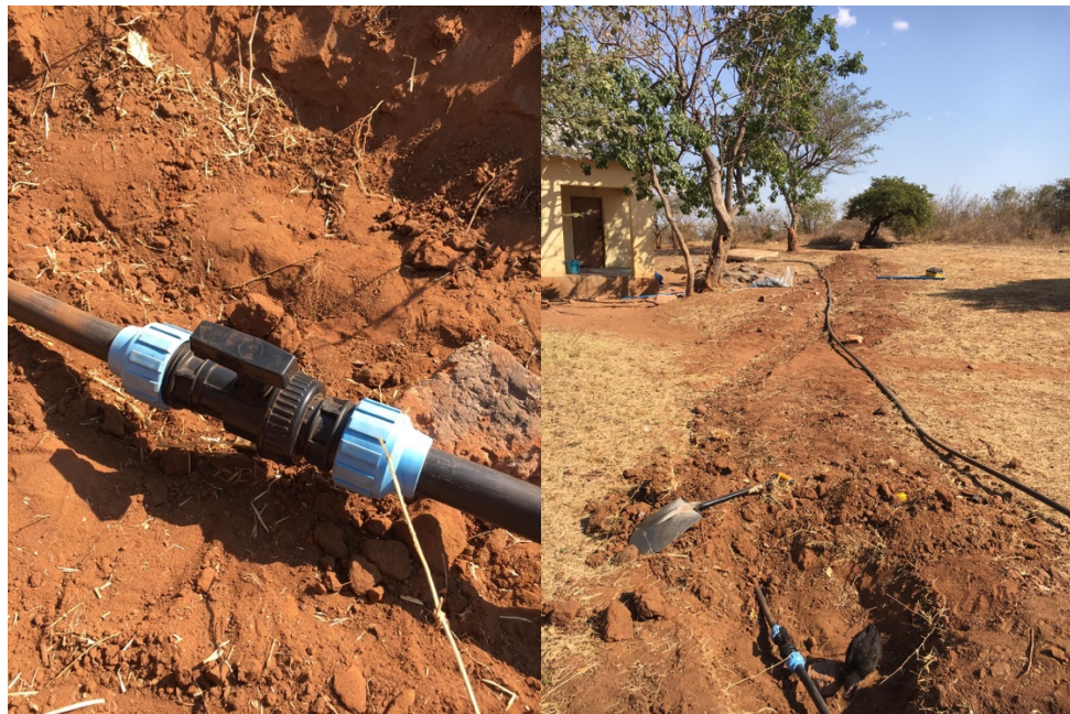
Ilustración 72: Válvula de seguridad
