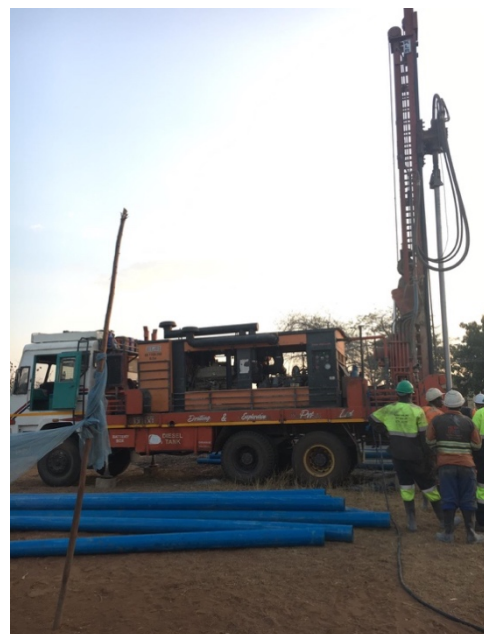
Ilustración 52: Tuberías de PVC
