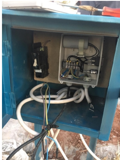
Ilustración 79: Caja de conexión
