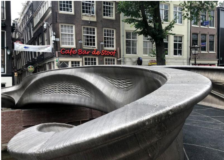
Ilustración 21: Puente metálico MX3D en Ámsterdam impreso en 3D
