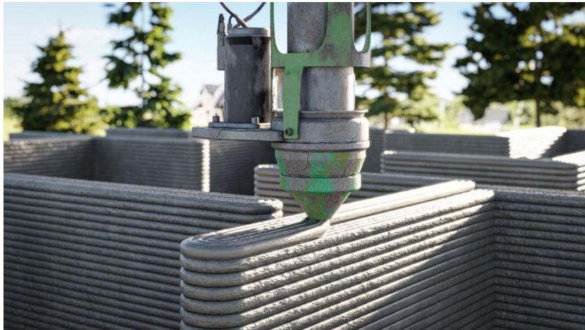
Ilustración 20: Construcción mediante 3D Concrete Printing
