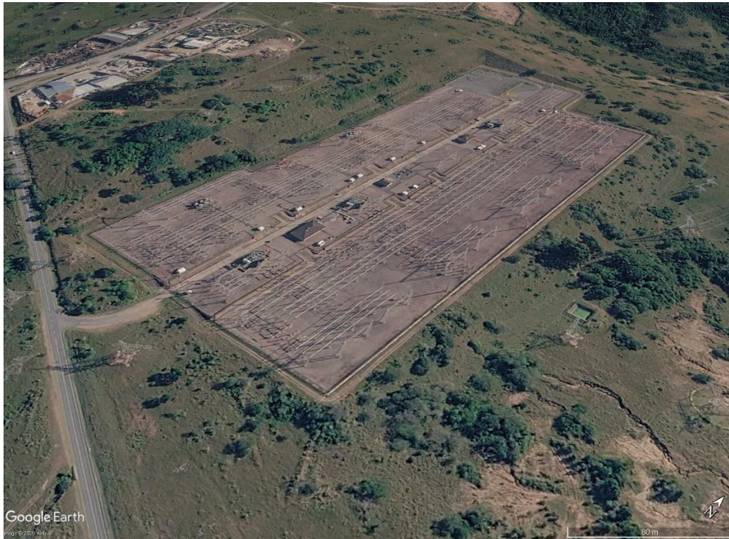
Ilustración 17. Vista de pájaro de la subestación Hector, cortesía de Google Earth
