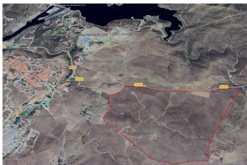
Figura 17 - Vista aérea emplazamiento
