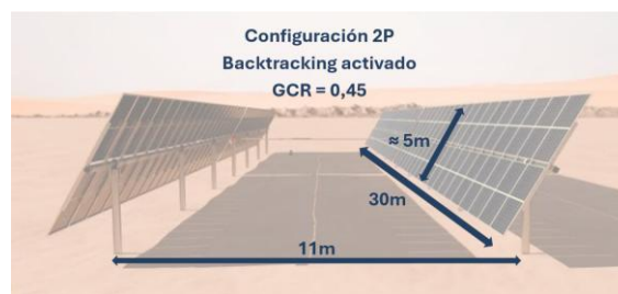
Figura 22 - Separación entre filas
