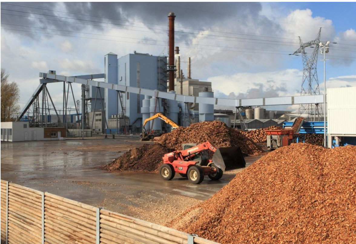
Ilustración 7: Residuos de madera triturada en planta de biomasa [4].
