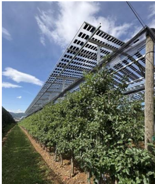
Figura 9: Panel solar semitransparente. Fuente: Brite Solar
