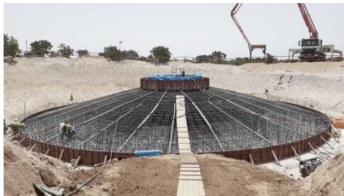
Figura 29: Detalle cimentación de un aerogenerador [50]
