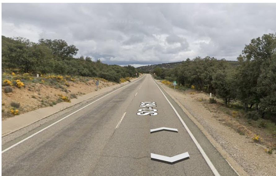
Figura 30: SO-160, carretera paralela al segundo emplazamiento
