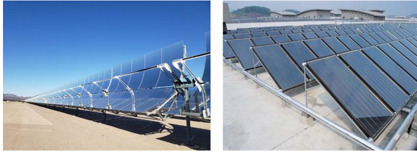
Figura 1: Comparación entre sistemas de captación solar térmica concentradores (izquierda) y no concentradores (derecha)
