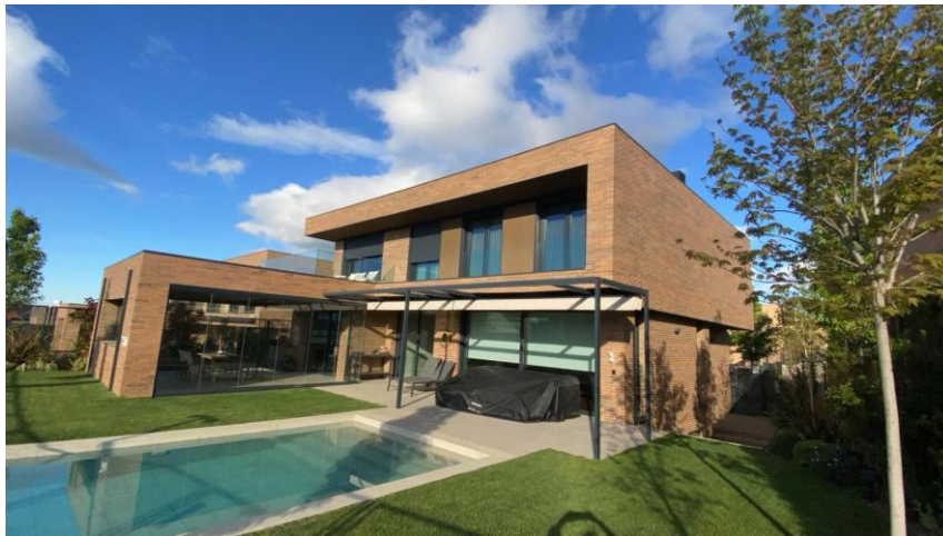
Figura 7. Fotografía de la fachada trasera de la vivienda (Fuente: Propietario)
