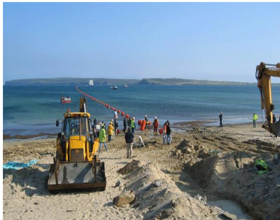
Ilustración 6.3 Tendido del cable submarino próximo a la costa.
