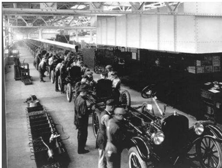
Ilustración 1.36 Cadena de montaje. Fuente: <http://www.fierrosclasicos.com/wp-content/uploads/2014/10/V.jpg>
