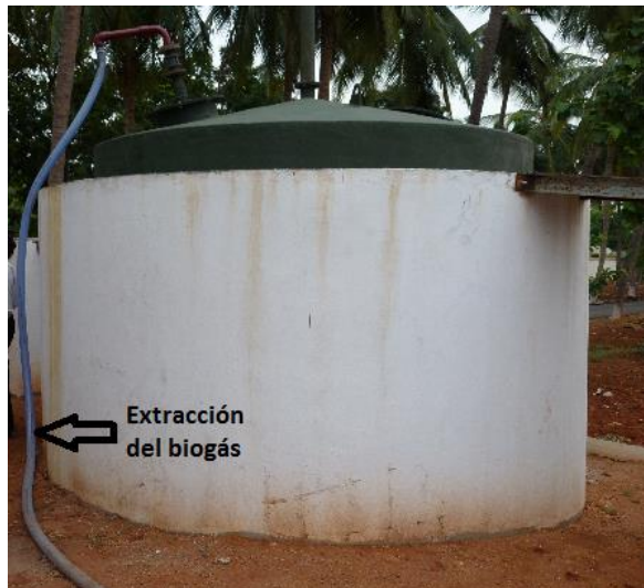
Figura. 10: Digestor de la planta de biometanización
