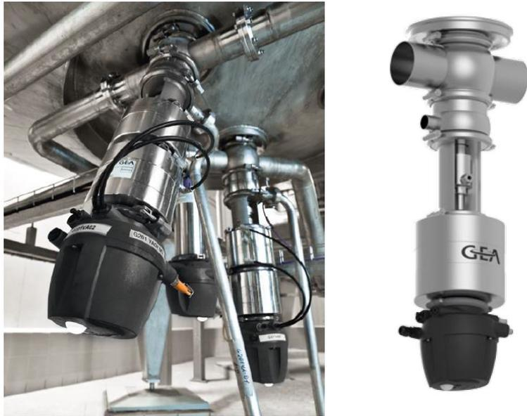
Ilustración 37: Esquema válvula tipo T
