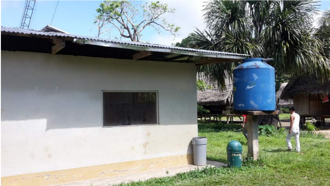
Ilustración 8 - Depósito instalado en el centro de salud de Villa Gonzalo
