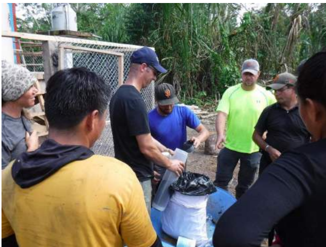
Ilustración 24- Introducción de carbón activo en la carcasa "big blue" (Corley, 2017)
