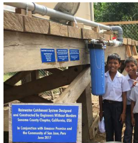
Ilustración 25- Instalación del filtro de carbón activo (Corley, 2017)
