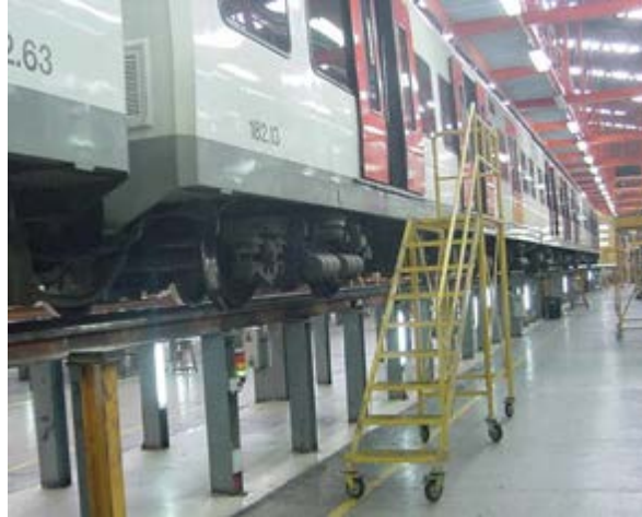
Figura 5: Vía sobre pilarillos, plataforma de acceso al tren.
