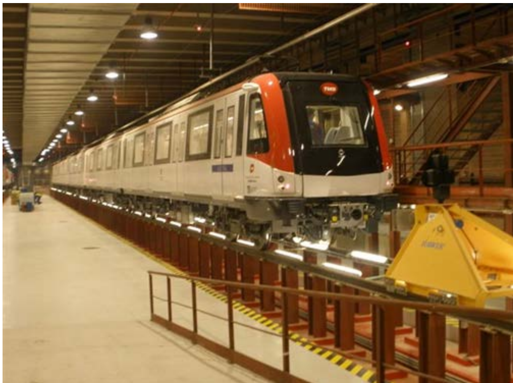
Figura 4: Imagen de un Foso Doble de mantenimiento de Primer Nivel..
