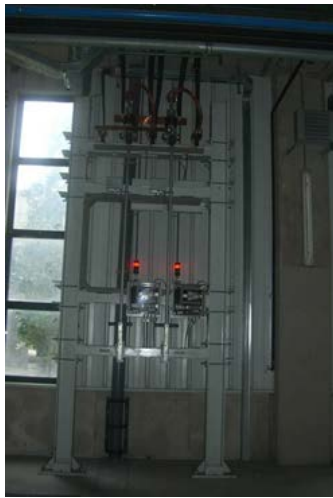
Figura 8: Seccionador Eléctrico de Catenaria e indicador lumínico de tensión.
