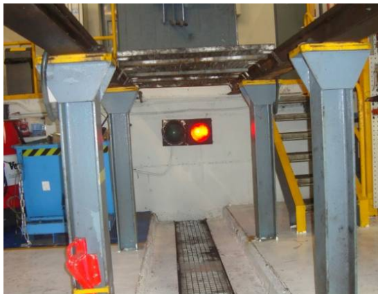
Figura 9: Indicadores lumínicos de tensión en foso.
