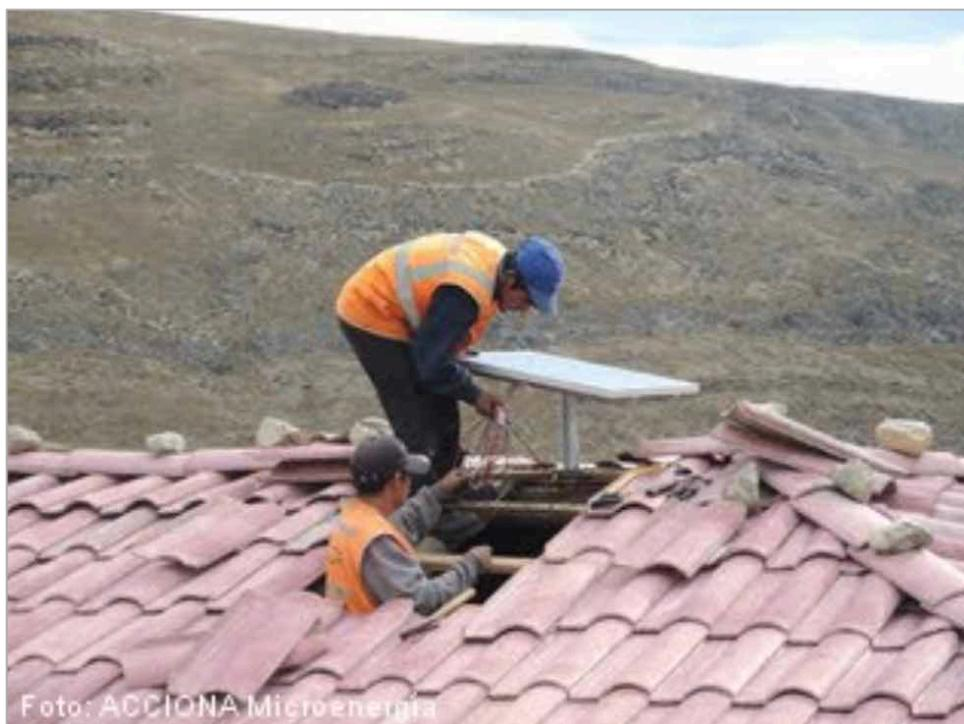
*Ilustración 12. Instalación del panel solar de un SFD en Cajamarca (Fundación ACCIONA Microenergía)*
