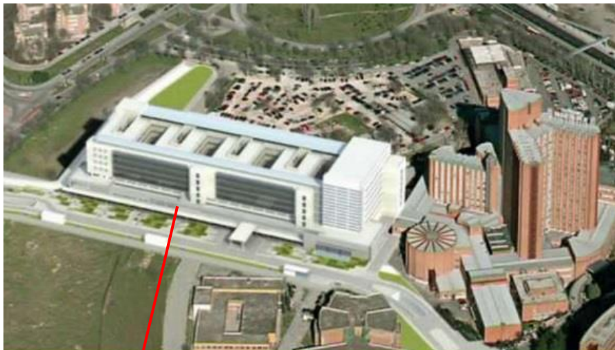
Figura 23: Edificio de rehabilitación
