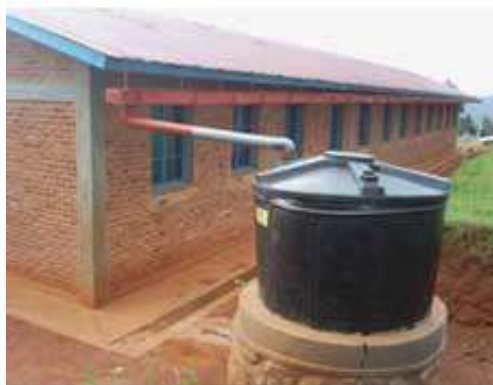
Ilustración 2 Sistema de recogida de agua de la lluvia en una escuela de Burundi.
