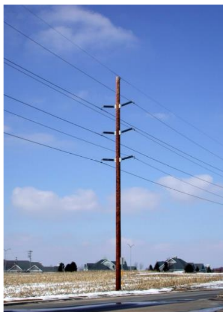
Ilustración 18. Apoyo tubular de madera laminada
