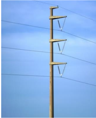
Ilustración 16. Apoyo tubular de hormigón
