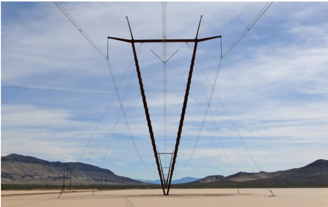
Ilustración 4. Torre en V atirantada
