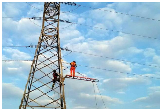
Ilustración 22. Tendido de cable FOADK
