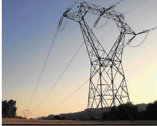
Ilustración 13. Apoyo de celosía
