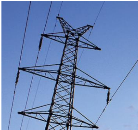
Ilustración 5. Cadenas de suspensión
