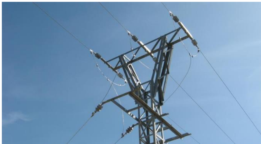
Ilustración 11. Apoyo especial con derivación
