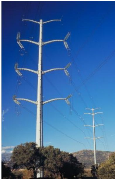
Ilustración 14. Apoyo tubular de chapa plegada
