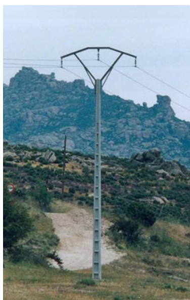
Ilustración 15. Poste de hormigón
