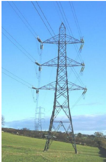
Ilustración 8. Apoyo de ángulo
