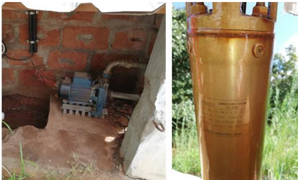
Ilustración 23. Izq: motor eléctrico de bombeo de agua. Drch: bomba sumergible. Fuente: elaboración propia
