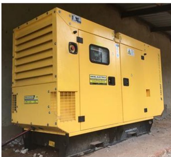
Ilustración 21. Grupos electrógenos diésel. Izquierda: GE 48kW. Derecha: GE 40kW. Fuente: elaboración propia
