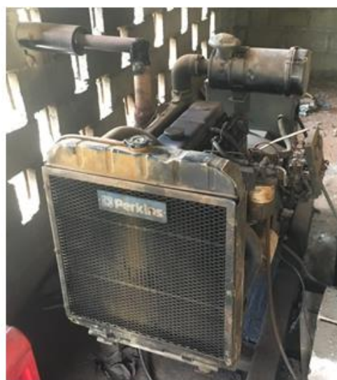
Ilustración 21. Grupos electrógenos diésel. Izquierda: GE 48kW. Derecha: GE 40kW. Fuente: elaboración propia
