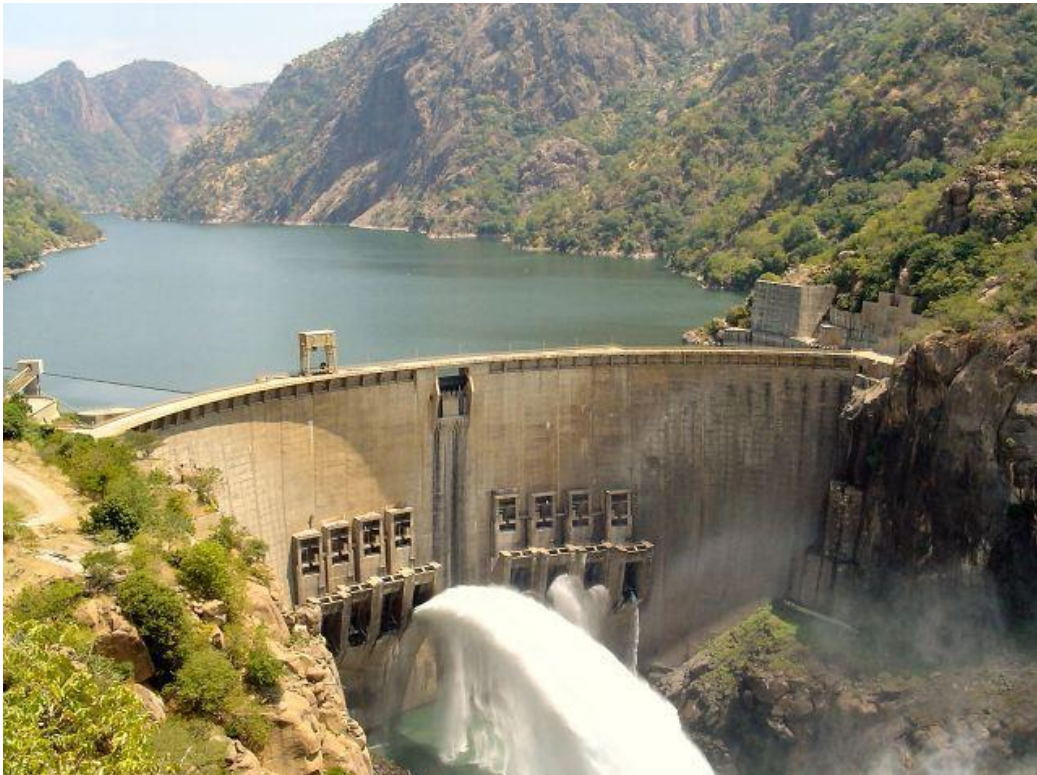
Ilustración 4. Central hidroeléctrica de Cahorra Bassa. Fuente: HCB
