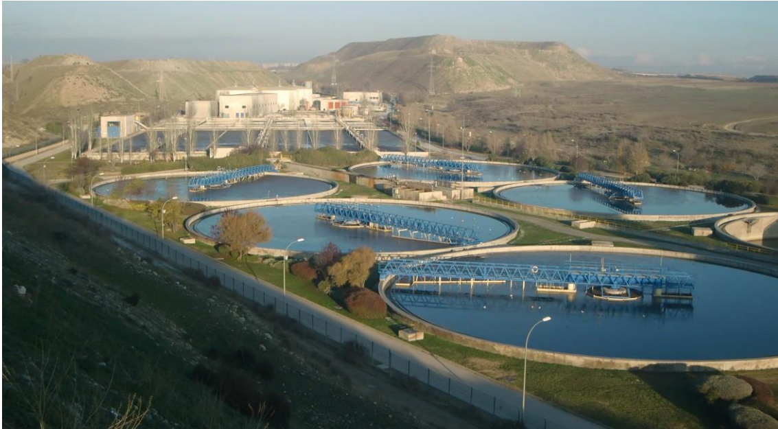
Figura 8: Vista de la EDAR de La Gavia
