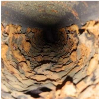
*Ilustración 7: Tubería corroída. Fuente: español.lubrizol.com*
