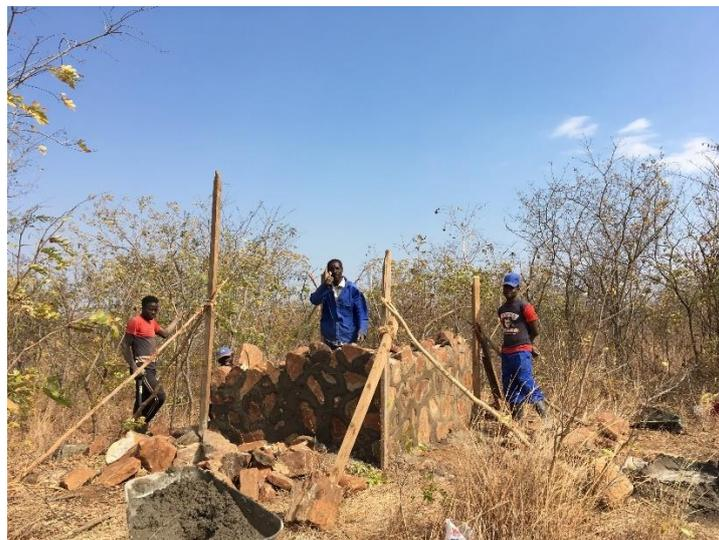
Ilustración 22: Construcción de la estructura de los tanques. Fuente: Propia
