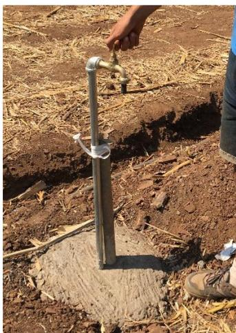
*Ilustración 9: grifos de la instalación. Fuente: propia*
