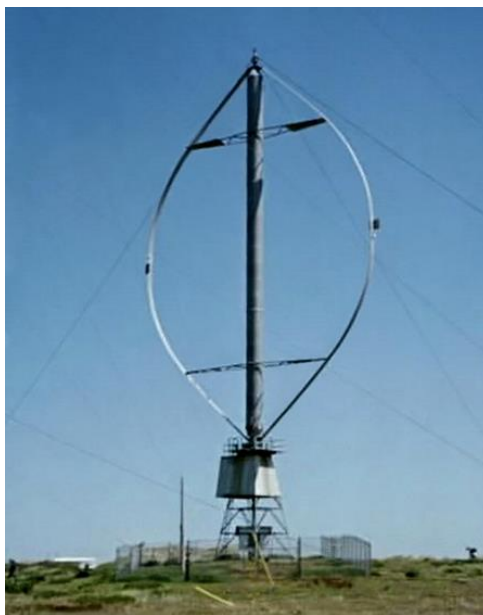
Figura 2-1. Aerogenerador tipo Darrieus. FUENTE: (10).
