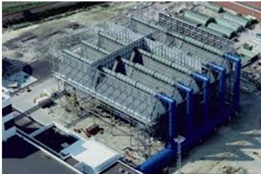
Figure 10- Air Condenser (ACC), Source [Curso de Introducción de Técnicas Reunidas]
