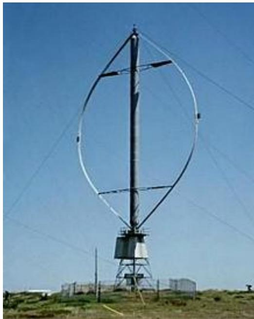
*Ilustración 14: Turbina eólica Darrieus [23].*
