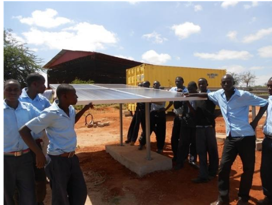
Ilustración 5: Instalación de placas solares en Kenia. Fuente: Amigos de Nyumbani
