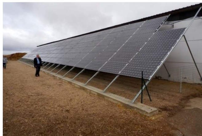
Ilustración 6: Instalación de placas solares en Camerún. Fuente: Energía sin Fronteras
