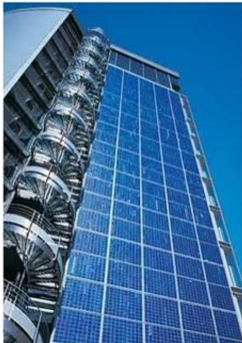
Ilustración 17: Instalaciones fotovoltaicas para el edificios comerciales. Fuente: aulagreencities
