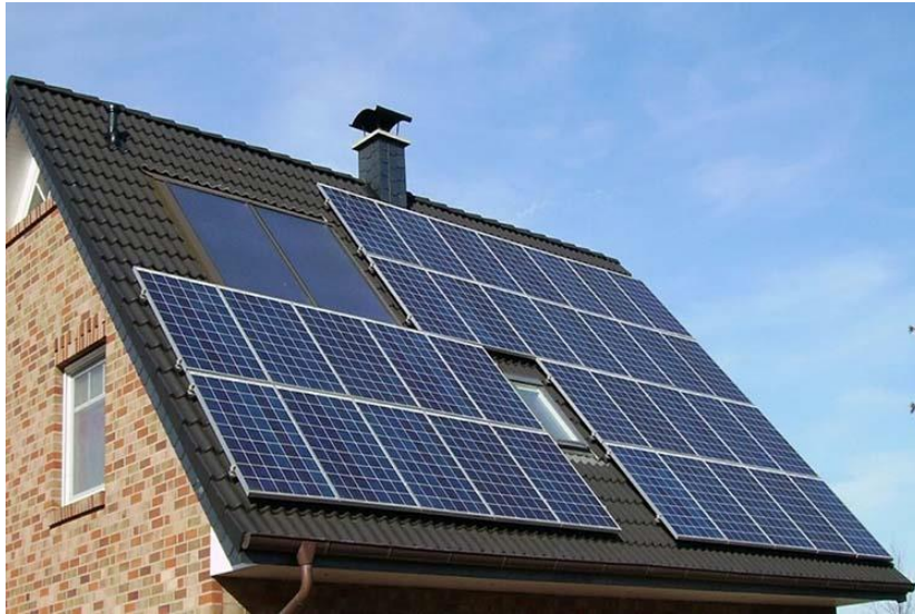
Ilustración 16: Instalaciones fotovoltaicas para el sector residencial. Fuente: Energy News
