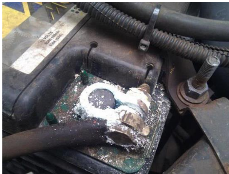
Ilustración 37: Acumulación de sulfato en los bornes de la batería. Fuente: Comercial Caravanning
