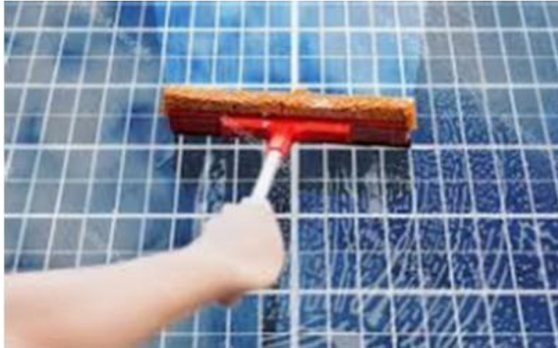
Ilustración 36: Limpieza de la suciedad de los paneles solares. Fuente: Generatuluz
