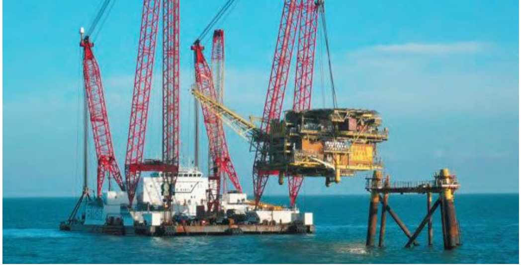
Figura 6- Eliminación de los topsides en una sola pieza
