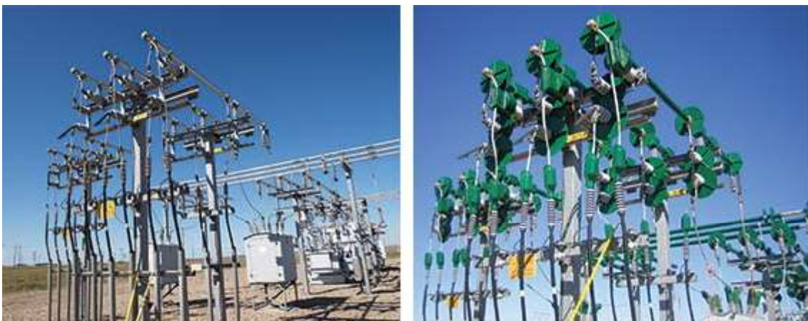
Ilustración 42: Aparata eléctrica de media tensión antes y después de la instalación de cubiertas.
