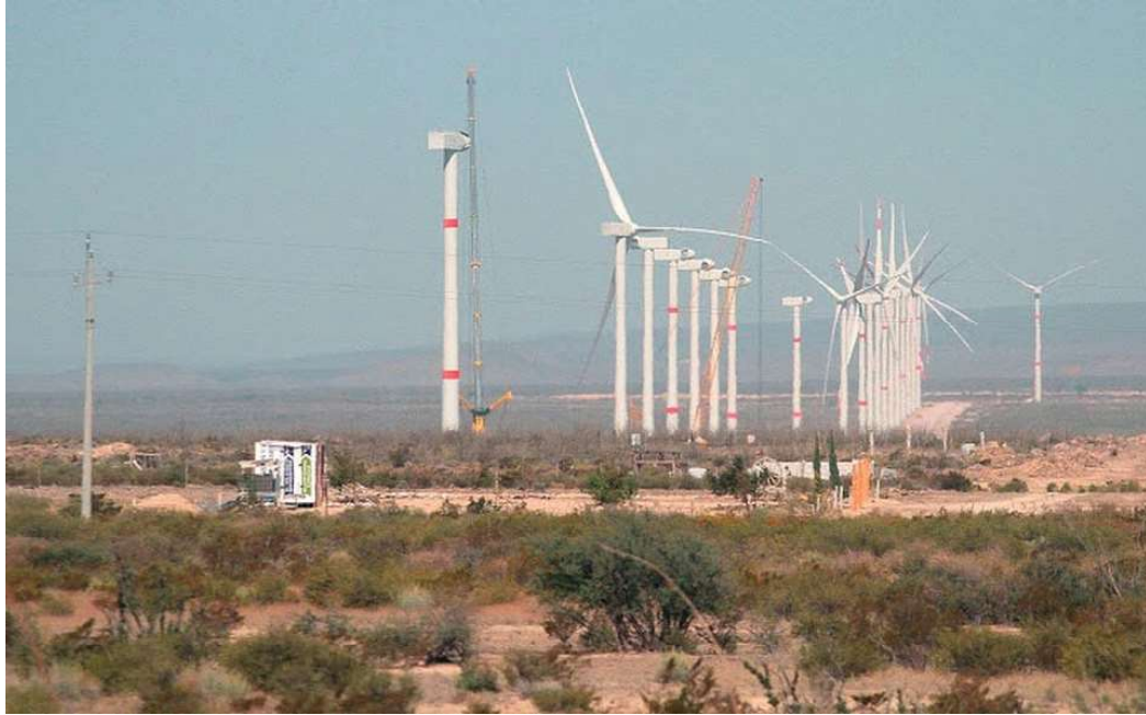
Ilustración 2: Parque Eólico en General Cepeda
