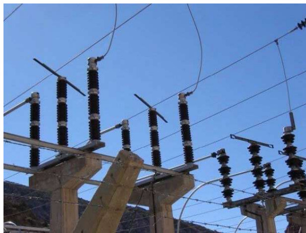
Ilustración 12: Seccionadores de columna central. Fuente: Ingeniería Eléctrica Explicada
