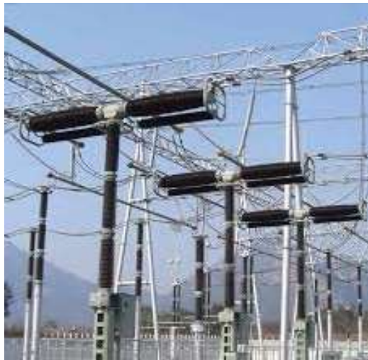
Ilustración 19: Interruptor automático de tanque vivo. Fuente: Siemens
