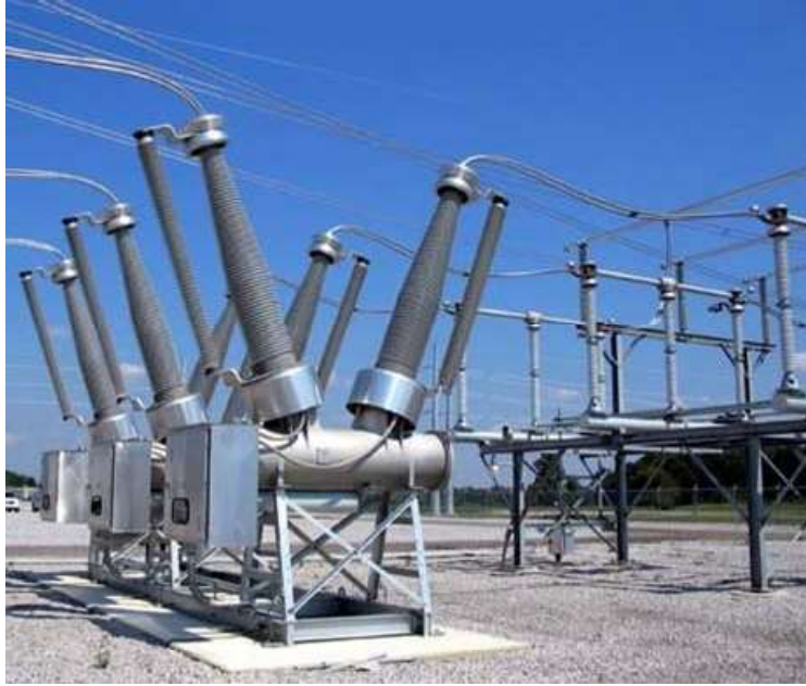
Ilustración 18: Interruptor automático de tanque muerto. Fuente: Eltrotec
