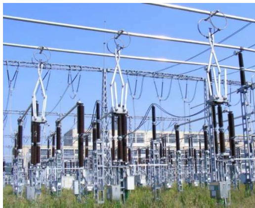
Ilustración 13: Seccionadores de pantógrafo. Fuente: Coelme
