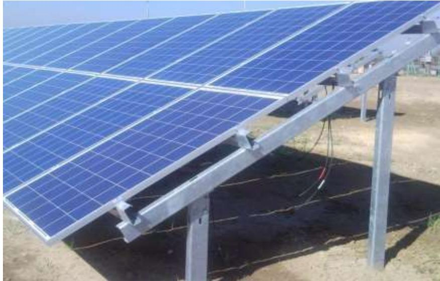
*Ilustración 11: Estructura de soporte fija. Fuente: Industrias Duero*
